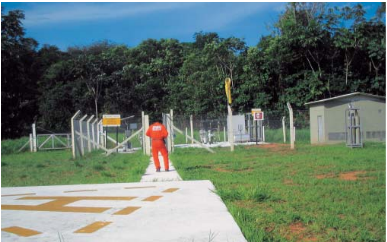
Hoje, chega-se às UTRs (construção à dir.) de helicóptero. Porém, no start-up do Terminal, em 1998, o acesso era possível apenas por barco e caminhada pela mata, pois ainda não havia helipontos
